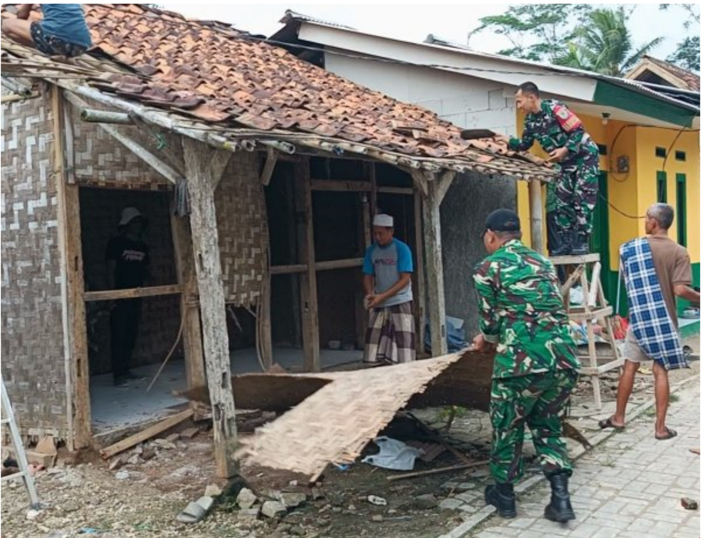
Pembongkaran Rumah Bapak Narmin
