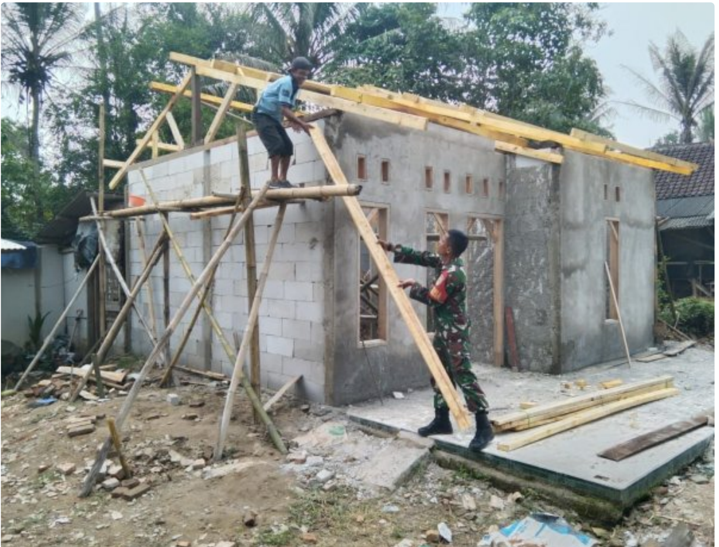
Serda Naya membantu pemasangan atap RTLH
